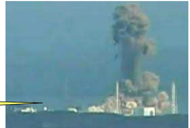
3 réacteurs de la centrale explosent, du 12 au 15/03, suite à la décomposition de la vapeur d'eau  $2\text{H}_2\text{O} \rightarrow 2\text{H}_2 + \text{O}_2$ , qui libère de l'hydrogène hautement explosif à température normale
